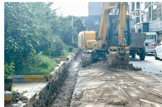
近日,金榜华府小区投入20多万元,实施下水道升级改造工程,提升排水能力。(曹殿贵 魏士化 摄)
