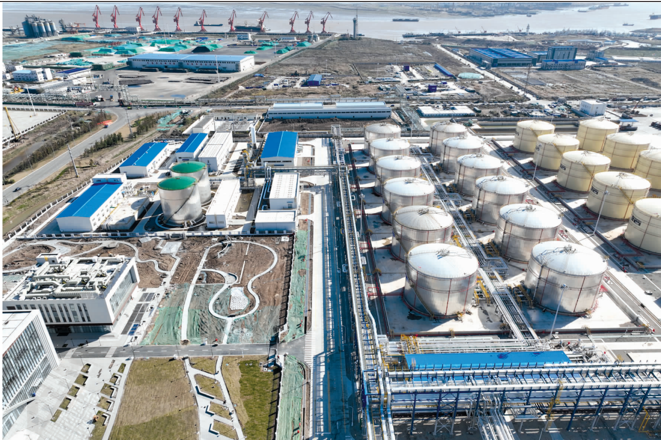
连云港嘉澳新能源有限公司生物航煤项目一期总投资约44亿元，于2023年1月开工建设。项目建成后可年产生物航空煤油37.3万吨、生物石脑油4.3万吨、生物柴油0.2万吨、硫磺102吨，助力交通领域每年减少碳排放约192万吨。
