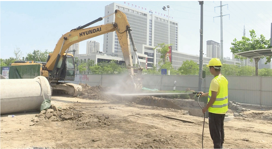
为了保障城区防汛安全，我区提前对城区部分排水管网开展清淤、维护、升级、改造等工作，确保汛期各类排水管道畅通。为了赶在汛期前完工，不影响道路正常交通，施工人员抢抓晴好天气，顶着高温作业，全力加快项目建设步伐。 仲卫卫 焦子妍 摄
