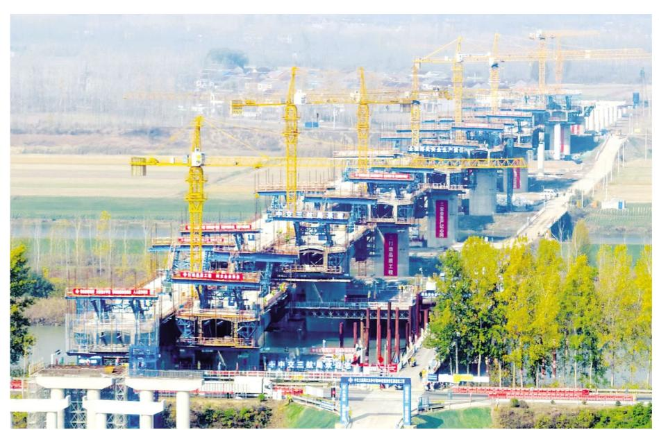
12月9日凌晨，经过5个小时的紧张作业，264省道淮安区段工程苏北灌溉总渠暨淮河入海水道特大桥80米大跨度连续梁边跨顺利合龙。此次作业为其他合龙段的施工积累了宝贵经验，提供了合理技术参数，也为特大桥早日贯通打下坚实基础。
