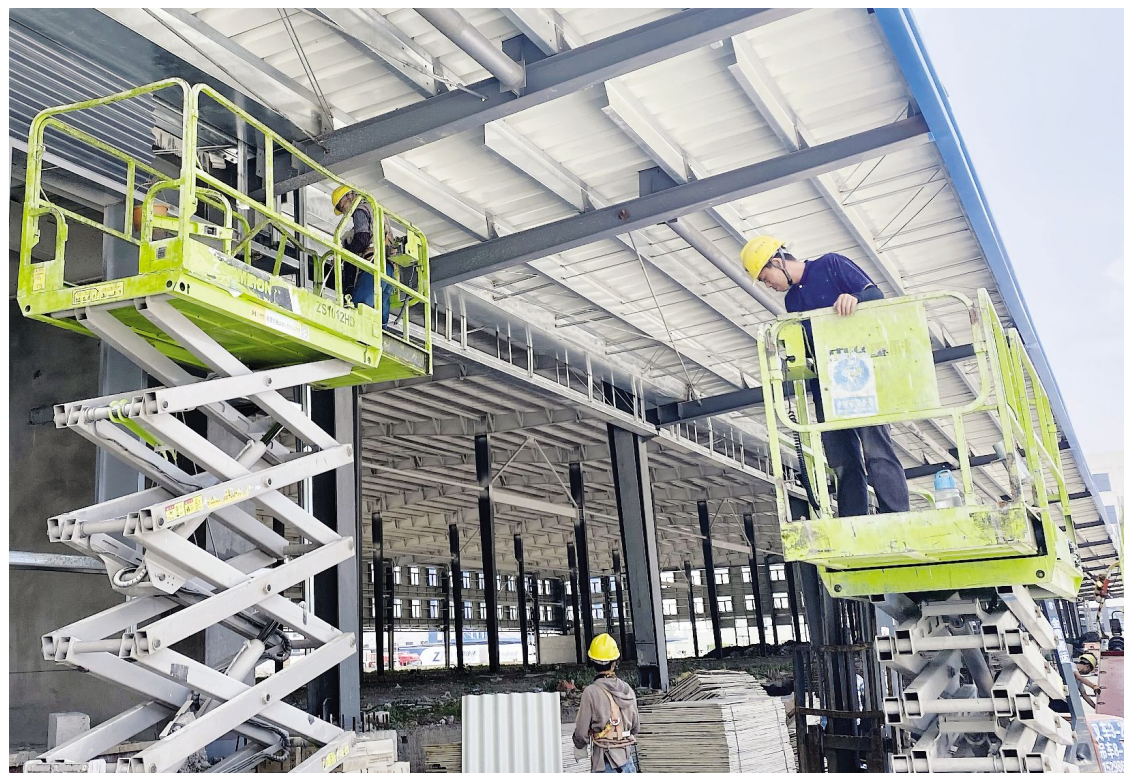
火热的六月，正是项目建设的黄金期。在中通快递四期项目现场，施工人员正在紧张施工，全力推进项目建设进度。据了解，该项目计划投资10亿元，占地约100亩，新建快递分拣、倒班楼等约10万平方米。项目竣工投产后预计每年可实现开票销售8亿元、入库税收2000万元。
