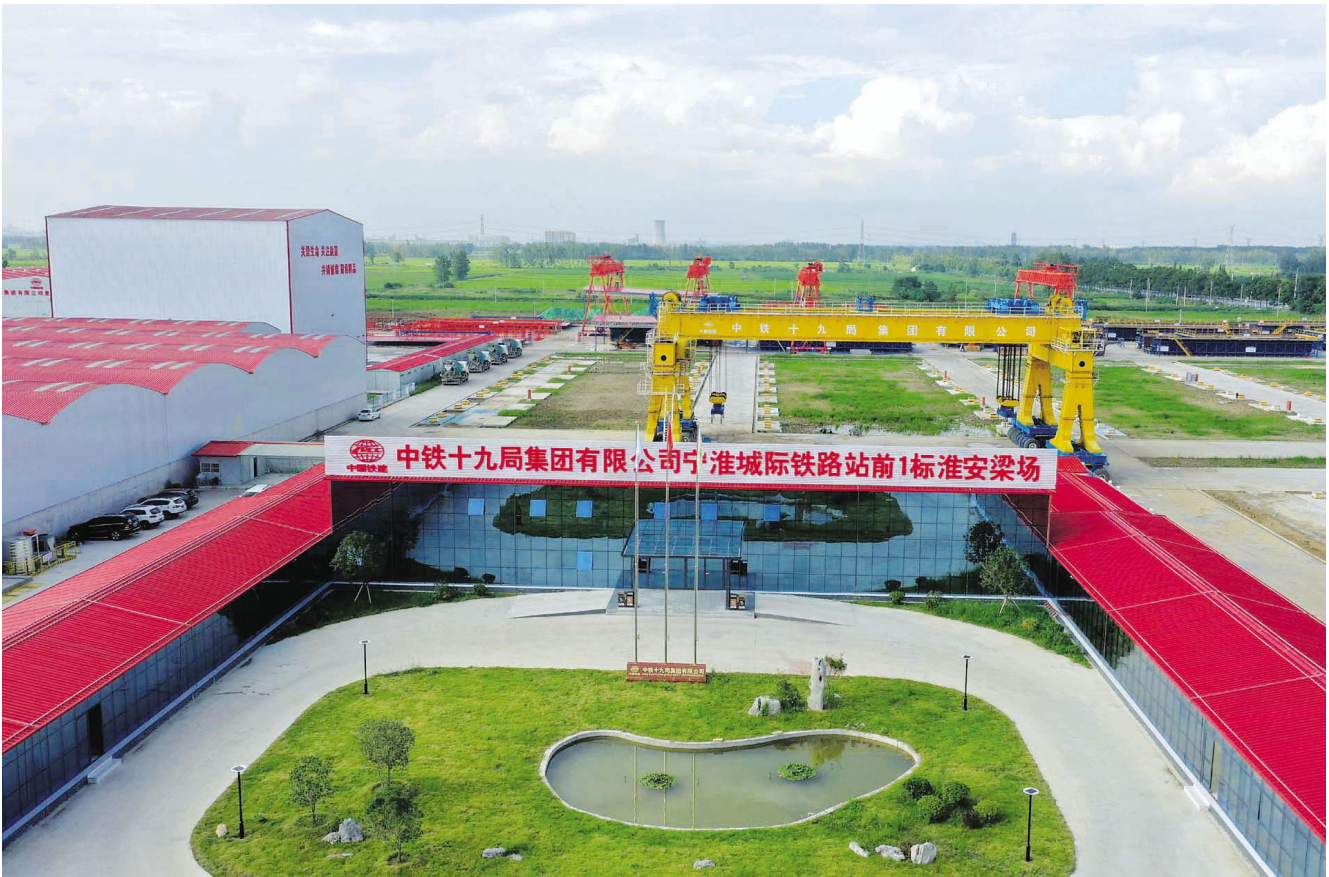
日前，记者在宁淮城际铁路站前 1 标准安梁场看到，工人们正忙着调试设备，为首孔箱梁生产做好准备工作。
