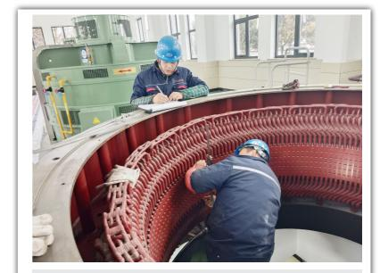
日前,菱陵抽水站组织技术人员对全站电动机、控制柜、变压器、控制系统等进行全面巡查、检修,确保抽水站在汛期充分发挥作用,保证受益范围内群众生产生活安全。图为技术人员在测量定子磁场
