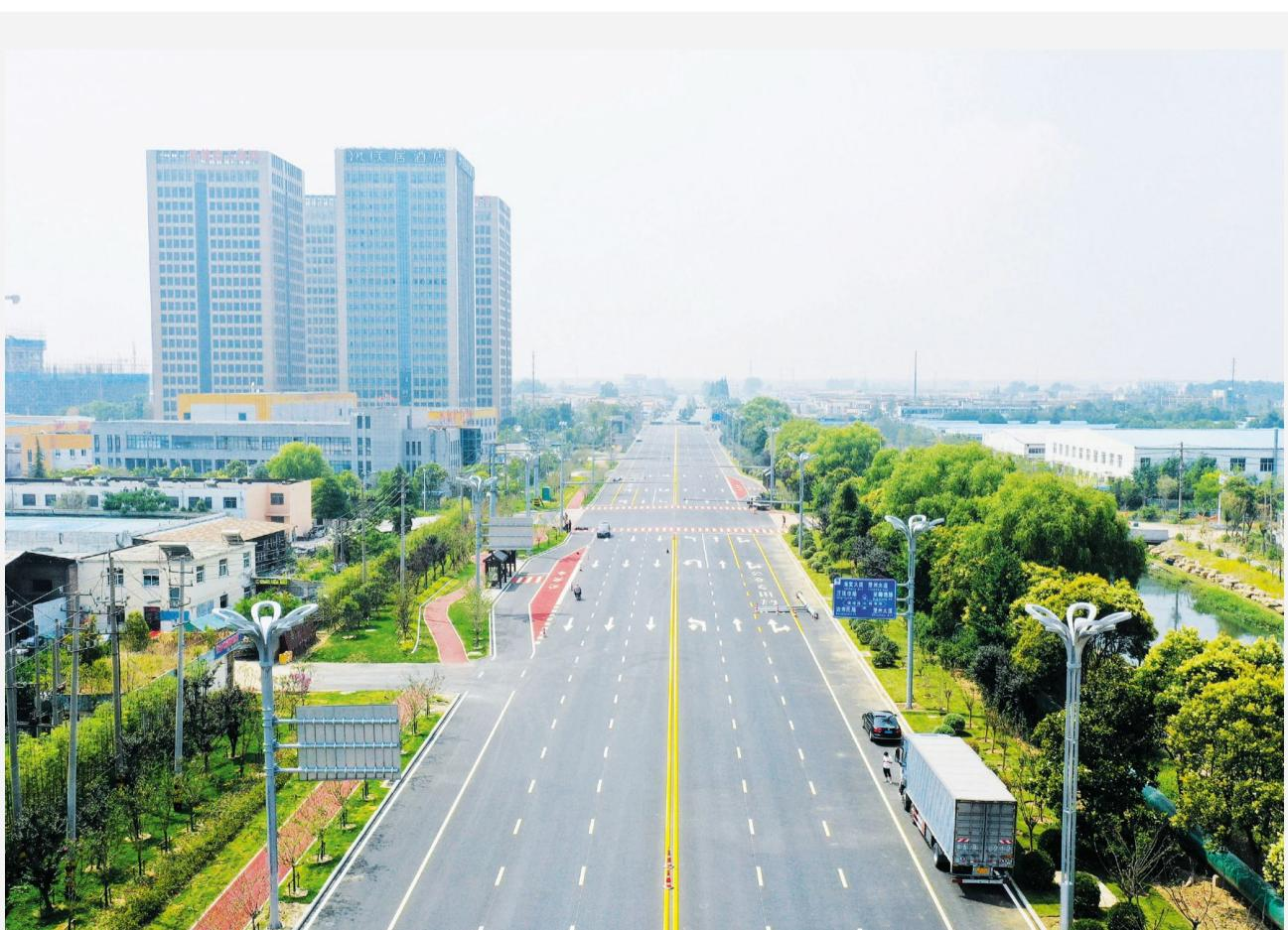
6月21日,记者在铁云路(承恩大道至海棠大道段)改造工程现场了解到,该项目排水、路基、路面、路灯工程均已完工,目前已进入最后收尾阶段,预计本月底通车。铁云路改造工程起于承恩大道,向南与山阳大道、翔宇大道相交,终于海棠大道,路线长2.775千米,按双向六车道一级公路兼城市主干路标准设计,设计速度50千米/小时,路面宽28.5米,项目总投资约7000万元。
