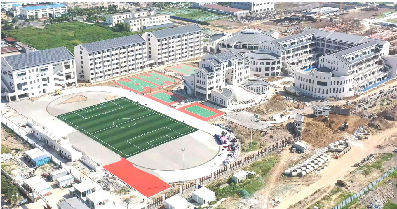
金陵中学淮安分校初中部加快校舍工程收尾工作，全力确保项目如期交付使用。据了解，该校于去年7月开工建设，总建筑面积约36681平方米，拟设置30个班，容纳学生1500人。目前，室内总体进度超90%，即将进入教育设备安装阶段。室外工程达到85%，计划近期完成施工任务。金陵中学淮安分校初中部是我区引进优质教育资源合作办学，优化区内教育资源配置的创新探索，也是我区建设高质量教育体系的创新尝试。
