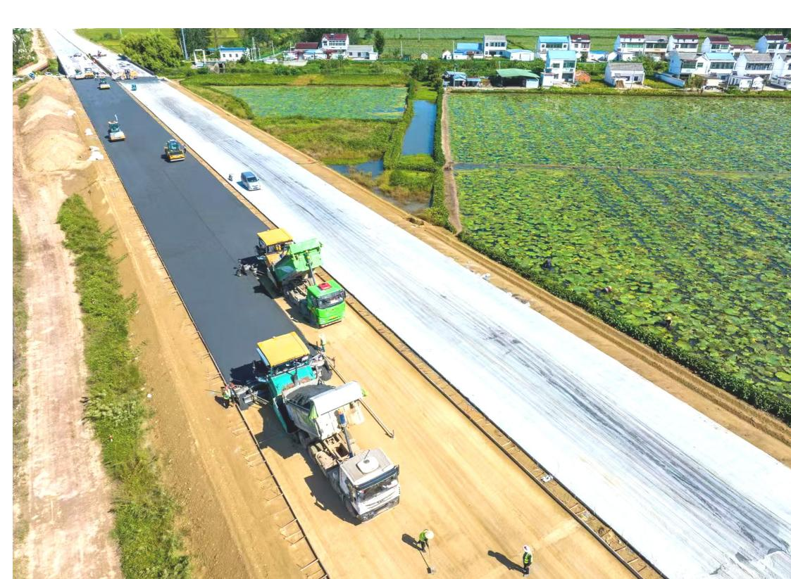
在264省道淮安区段建设工程施工现场，多台大型摊铺机、压路机等机械相互配合，严格按照施工要求，有序进行水稳基层铺设作业。截至目前，已完成底基层水稳摊铺(单幅)约37公里，标志着264省道淮安区段已全面进入水稳层摊铺阶段。
