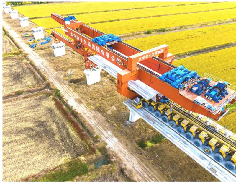
日前，记者在宁淮城铁铁路淮安段看到，在架梁机的牵引下，重达572吨的预制箱梁稳稳地落在墩柱上，目前工程全面进入箱梁架设阶段。
