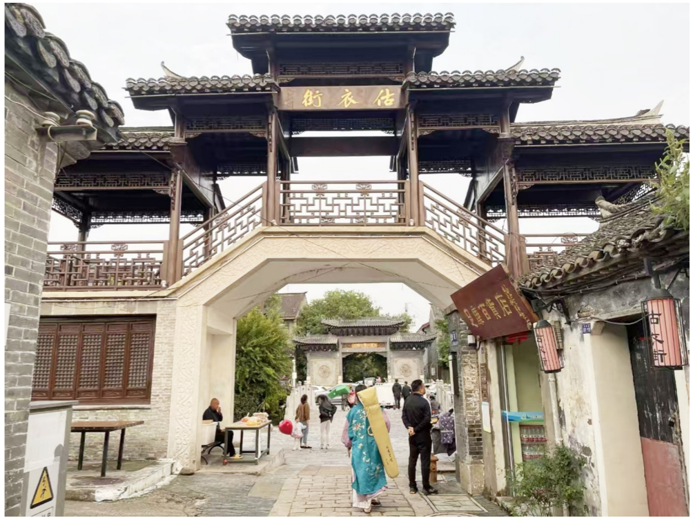
老估衣街的新过街楼 樊国栋 摄
