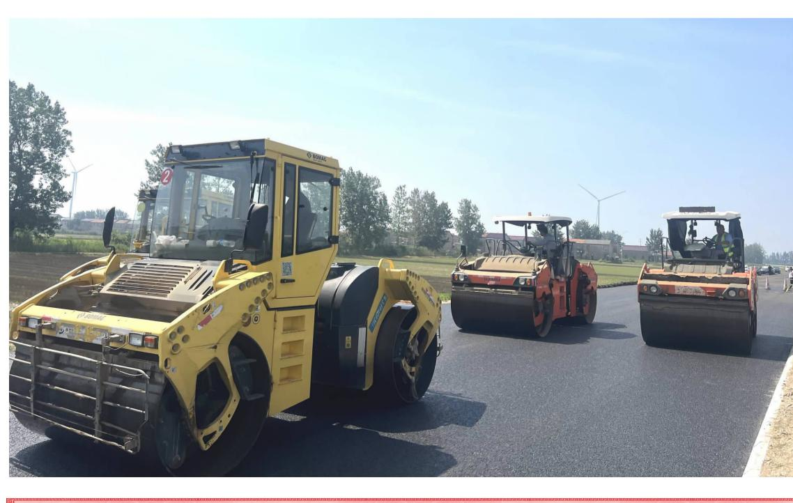
日前,记者在264省道淮安区4标段施工现场看到,摊铺机轰鸣作业,滚烫的沥青混合料腾起白汽。据介绍,针对高温天气,施工方调整了作业时间,避开正午高温时段,利用清晨和傍晚加班,截至目前已完成工程量的97%。
