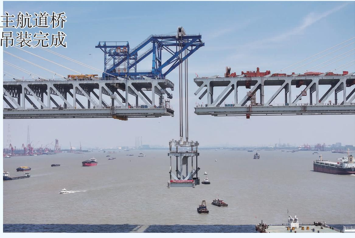
5月29日拍摄的常泰长江大桥主航道桥合龙段钢桁梁吊装现场(无人机照片)。当日,常泰长江大桥主航道桥最后一节钢桁梁——合龙段钢桁梁顺利吊装到位,拉开主桥合龙的序幕,预计6月上旬完成合龙,实现全桥贯通。常泰长江大桥连接江苏省的常州市与泰州市,是一座集高速公路、城际铁路、普通公路于一体的过江通道。
