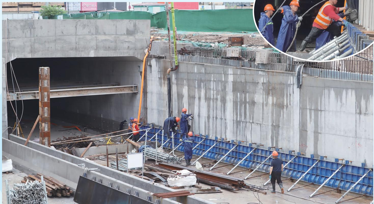
昨日,记者在江海路提升改造工程隧道段施工现场看到,工人们正冒雨对隧道外侧防撞墙进行打浆灌注。11日夜间至白天是近期雨势最大的时间段,为保障正常施工,现场七台水泵同时运作,确保隧道内无积水。
