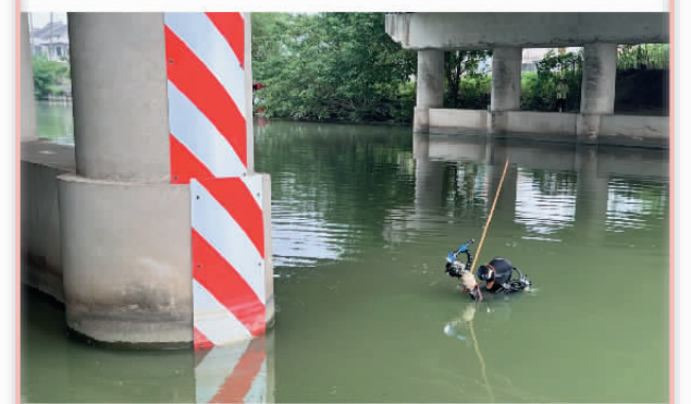
图为“蛙人”对位于三星镇的彦英桥水下桩基病害情况进行图像采集。
