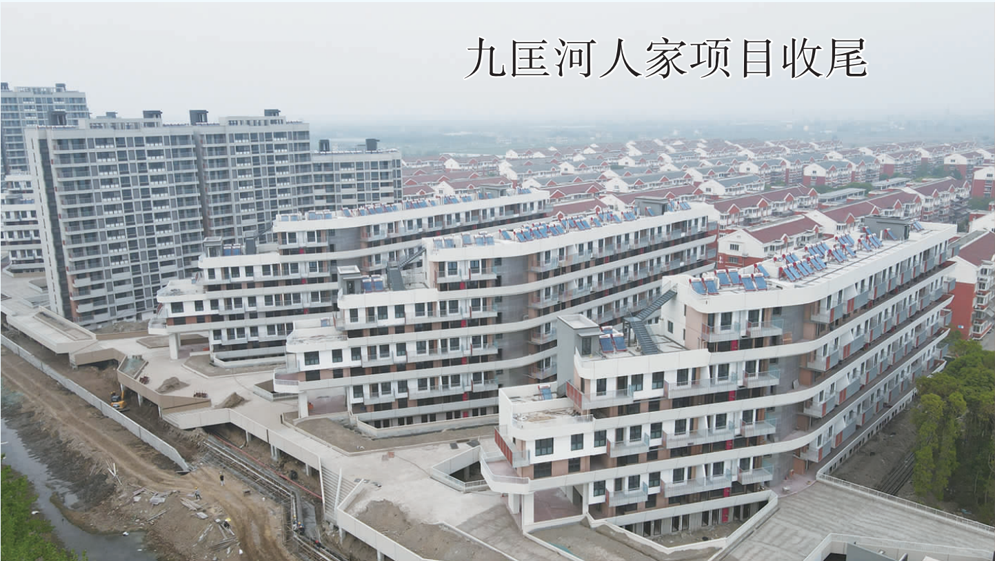
九匡河人家安置小区项目位于临江新区九匡河东侧、旭日花园西侧，总投资约3.8亿元，建成后可安置住户606户。目前，该项目已进入收尾阶段，预计将在今年下半年竣工交付。图为前日，项目建设现场。
