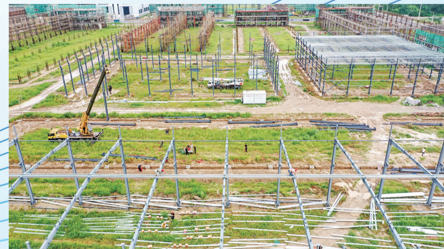
模具产业园生产工地外景
