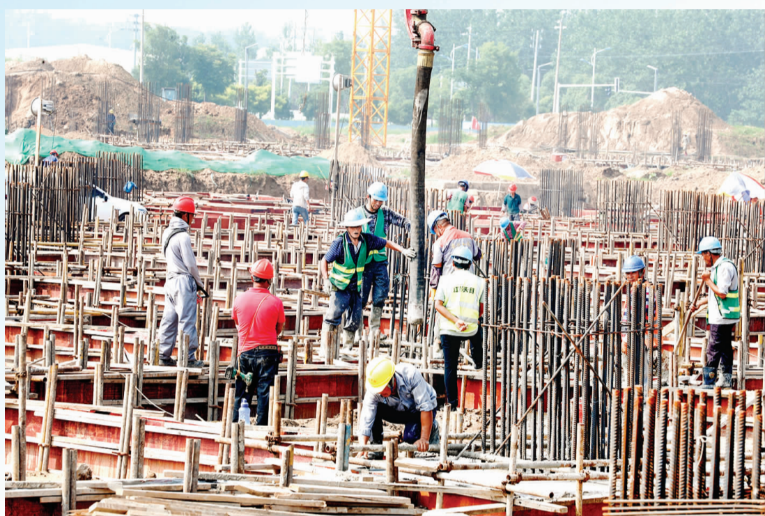
中天钢铁新材料年产150万吨精品钢帘项目建设现场
