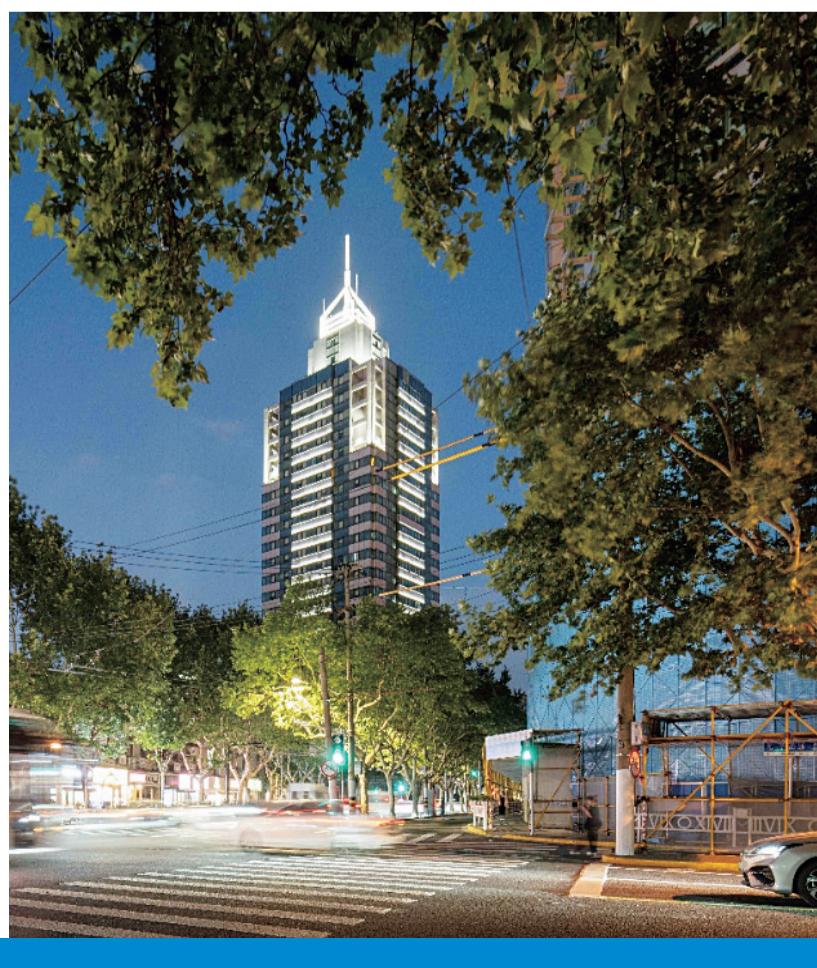
▲华山路天桥南侧夜景
