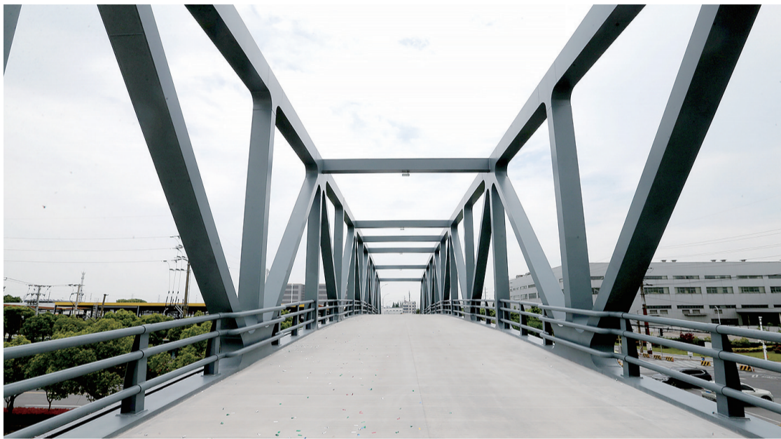
5月30日,作为上汽安吉物流新建安亭整车自动化立体库项目的配套建设项目——跨米泉路天桥(连通道)项目竣工,将连接上汽安吉物流公司两个片区。上汽安吉物流新建安亭整车自动化立体库项目总投资6.93亿元,建成后将成为全国最大的整车物流枢纽中心。
