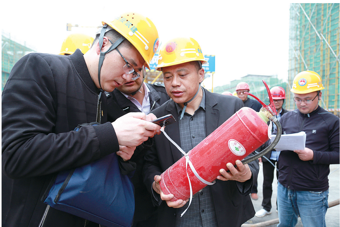
“五一”前夕，县住建局组织人员对全县建筑工地安全生产情况进行检查，深化安全隐患排查整治，压实企业主体责任，严防建筑安全生产事故发生。图为工作人员对建筑工地消防器材进行安全检查。 陈剑 刘杰 摄/文
