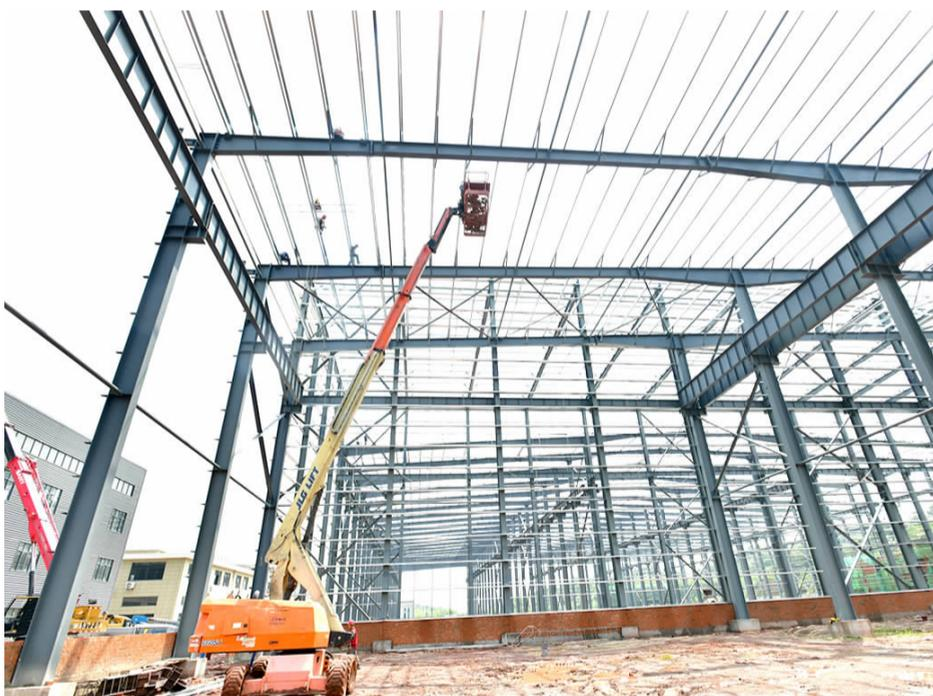
连日来，在位于大慈岩镇工业功能区湖塘区块的杭州屹通新材料股份有限公司雾化还原车间新建厂房建设工地，施工工人正在建设钢架结构的厂房主体工程。据悉，总占地面积达4.3万平方米的屹通新材新建厂房自今年初开工以来，已完成主体工程80%以上，预计8月初完工并陆续安装生产机器设备。
