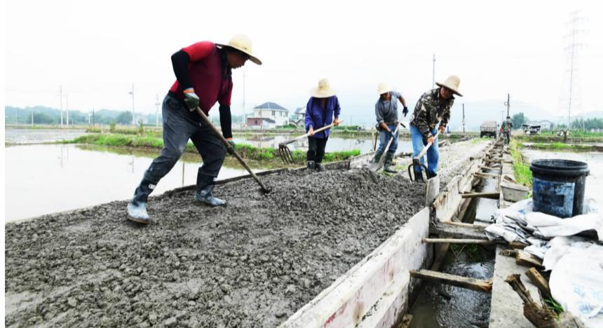
连日来，在寿昌镇红路村千亩方永久基本农田集中连片整治项目现场，施工人员正抓紧对田间道路、水渠等基础设施进行混凝土浇筑硬化等工作。自去年以来，该镇对西门、卜家蓬等五个村的农田机耕道路、排灌沟渠、闲置荒田等进行连片整治，以提升农田规范经营能力，为稳粮增效、改善农业生态环境发挥积极的作用。
