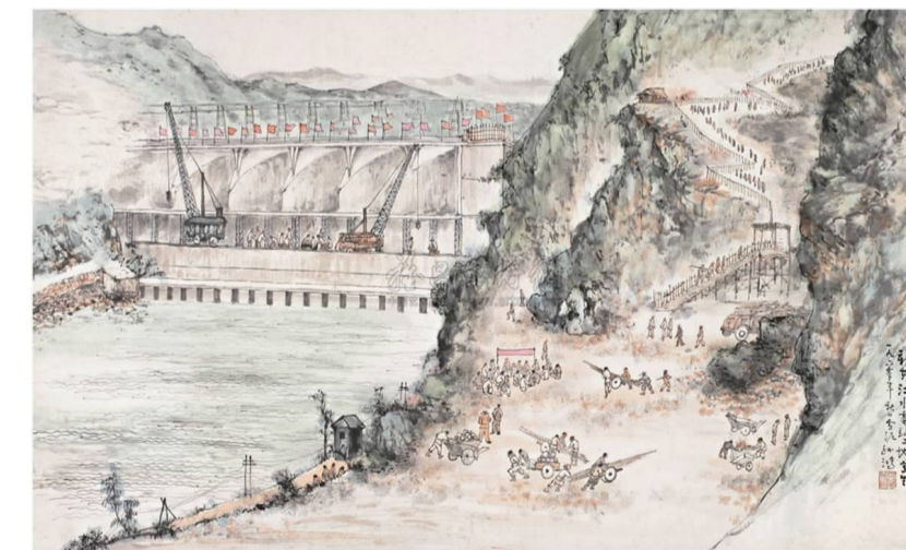
《新安江水电站工地写生》 孙雪泥 绘于1960年
