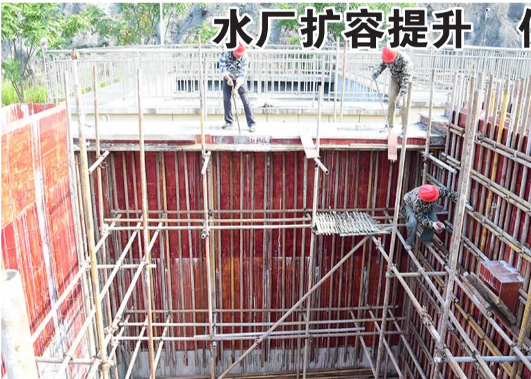
连日来，在大慈岩镇石柱源水厂扩容提升改造工程建设工地，建设者们冒酷暑赶工期，抓紧对絮凝池、沉淀池等新建供水设施进行浇筑与保养等工序。目前，该工程已完成85%左右，预计今年10月底前完成，届时水质将达到国家饮用水一级标准，每小时供水能力提高到200立方米，有力保障全镇百姓的生活用水安全。
