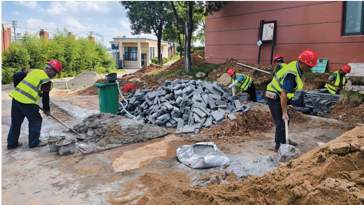
作为下蜀镇 2025 年重点民生实事项目，下蜀中学室外消防改造项目总投资近 77 万元，内容包括土石方处理、路面拆除与恢复、新建喷淋管网系统、室外消防栓管网及室内消防栓管网等。目前，正在进行消防管道开挖、消防井砌筑及管网铺设等施工，预计 8 月 20 日左右竣工交付。 潘雪芹 夏建玲 摄影报道
