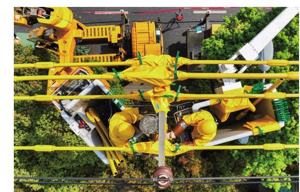
近日，在昌化镇10千伏昌南线，新剑线综合检修现场，国网杭州市临安区供电公司集结6支带电作业小组、1支配电作业小组、9辆绝缘斗臂车，对两条线路30至85号杆之间的架空线路进行设备检修。这是杭州地区首次采用集中式、军团化模式实施配网不停电综合检修，将“单线路、多点位、多班组”的配网作业新模式推向实践纵深，进一步提升区域供电可靠性。记者 吕静怡 余钱洋 通讯员 吴忱 摄
