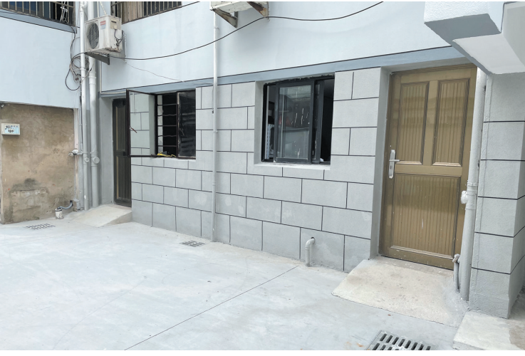
改造后的储物间
