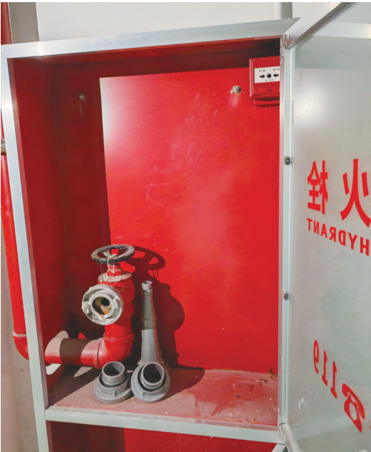
尚洋雅苑小区的消火栓内没有消防水带。
