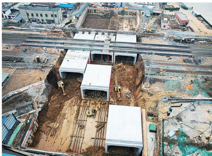
货运铁路专用线最大框构桥顶进施工现场,框构五桥在顶进中。
