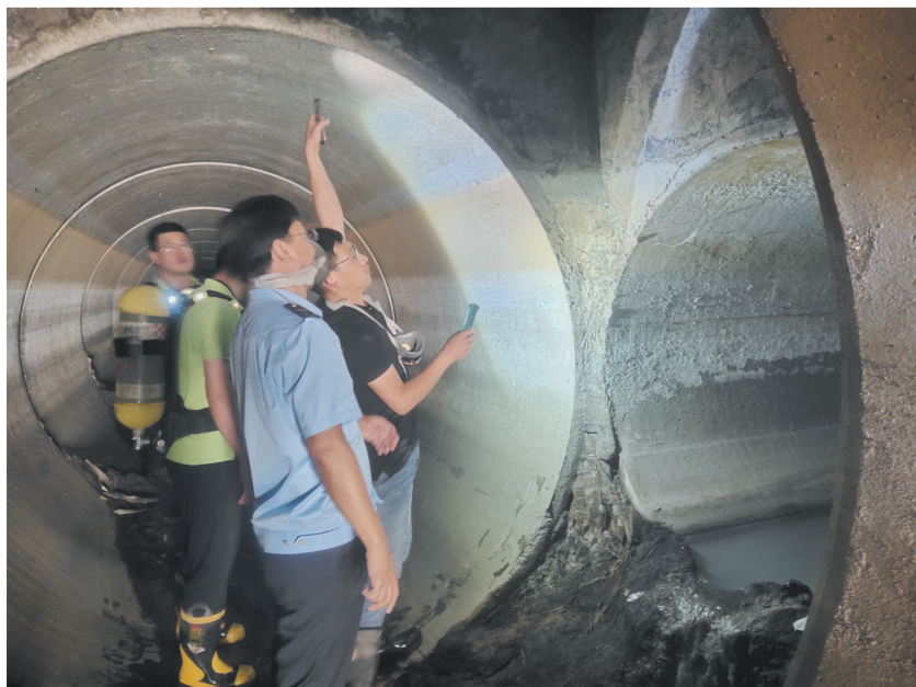
城镇污水管网集中式溯源排查。
