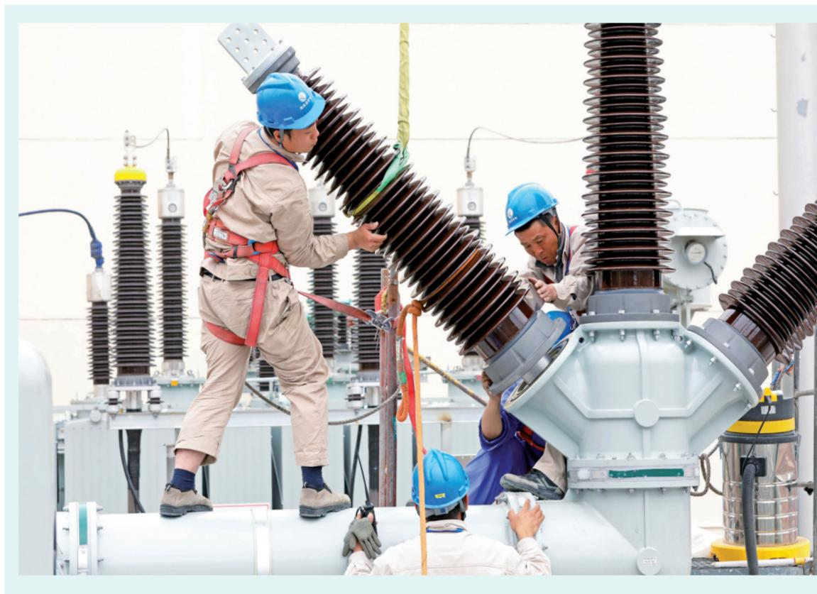
4月28日，国网连云港供电公司组织对灌云县110千伏西苑变电站进行改造升级，更换存在隐患的老旧变电设备，为灌云主城区迎峰度夏提供可靠保障。图为施工人员正在安装新的GIS高压套管。
