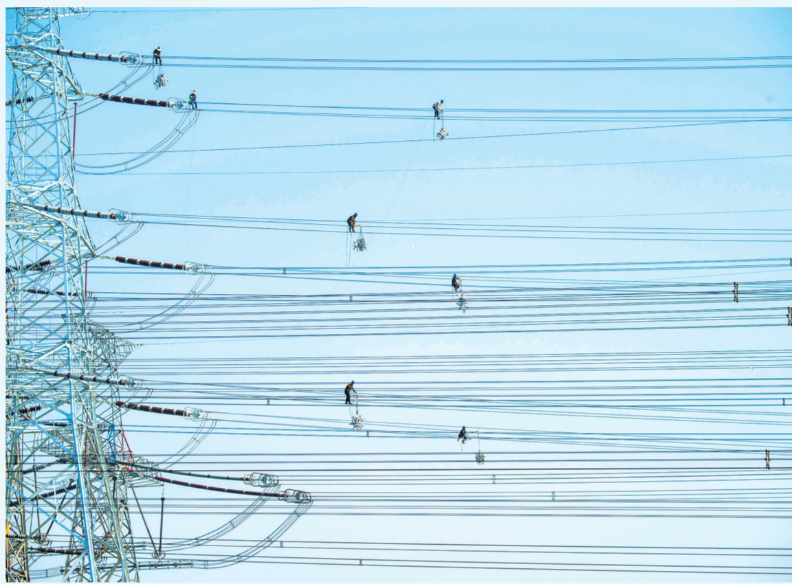
当前,作为我省今年迎峰度夏重点项目之一的西津渡 埋峰山 武南500千伏线路改造工程正加紧施工,力争6月底前竣工投产。图为5月21日施工人员正在70多米的高空安装间隔棒。 潘正光 摄文
