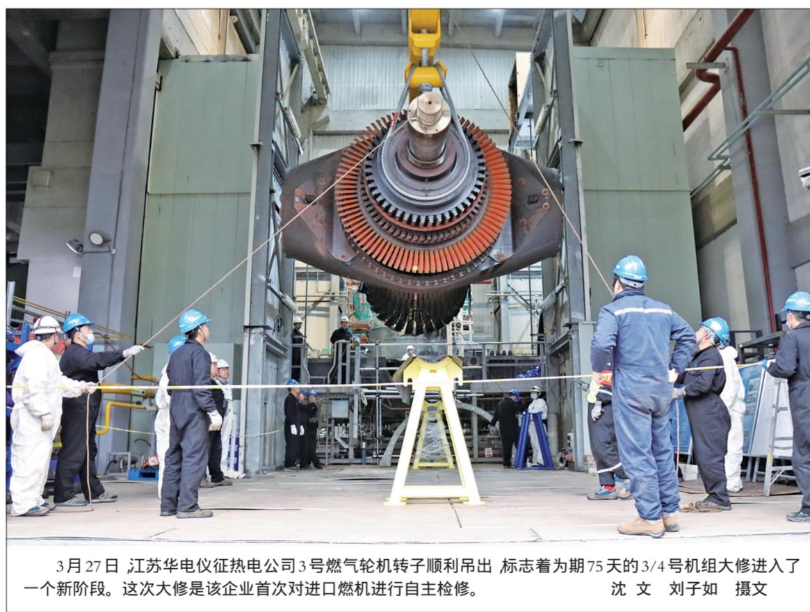
3月27日 江苏华电仪征热电厂3号燃气轮机转子顺利吊出,标志着为期75天的3/4号机组大修进入了一个新阶段。这次大修是该企业首次对进口燃机进行自主检修。
