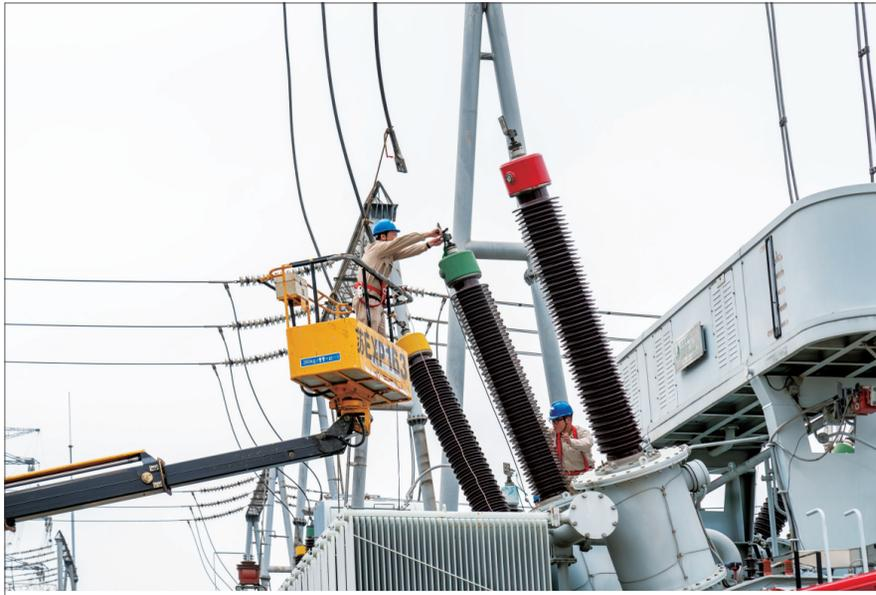
9月6日,苏州供电公司结合秋检,组织对220千伏七里庙变电站3号主变压器进行预防性试验,及时发现设备隐患,提高供电可靠性。
