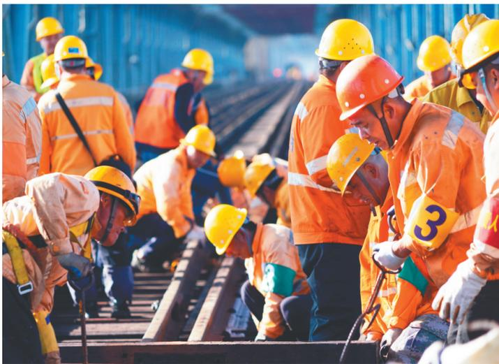
10月12日,南京桥工段南京大桥车间组织职工对南京长江大桥铁路明桥面进行大修。连日来,南京桥工段有序推进京沪铁路“集中修”,夯实运输安全基础。仇彬 张旭 摄
