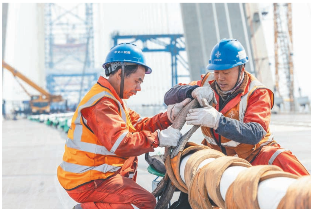
5月1日,中交二航局建设者在常泰长江大桥施工现场进行斜拉索安装作业。当日是“五一”劳动节,许多劳动者坚守岗位,以饱满的工作热情度过节日。
