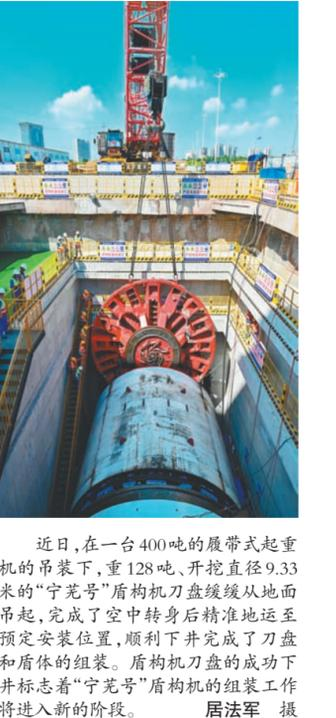
近日,在一台400吨的履带式起重机的吊装下,重128吨、开挖直径9.33米的“宁芜号”盾构机刀盘缓缓从地面吊起,完成了空中转身并精准地运至预定安装位置,顺利下井完成了刀盘和盾体的组装。盾构机刀盘的成功下井标志着“宁芜号”盾构机的组装工作将进入新的阶段。居法军 摄
