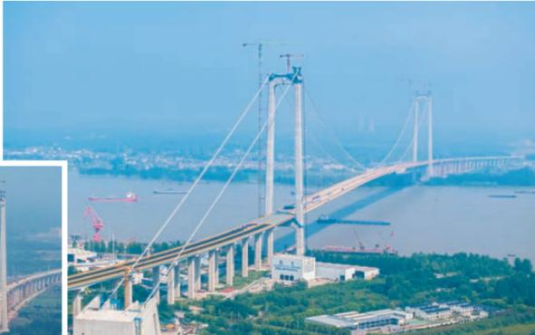
8月7日,南京龙潭长江大桥建设者不畏高温酷暑,坚守岗位,确保工程进度。龙潭长江大桥位于南京长江四桥与润扬长江大桥之间,北接扬州市仪征市,南接南京市、镇江市句容市,按双向6车道高速公路标准建设,设计时速100公里,全长4925米。龙潭长江大桥主桥为单跨吊钢箱梁悬索桥,主跨1560米,计划2024年底前建成。大桥建成后,对推动扬州市跨江融合发展、促进宁镇扬一体化具有重要意义。图为龙潭长江大桥初展雄姿,工人施工忙。
