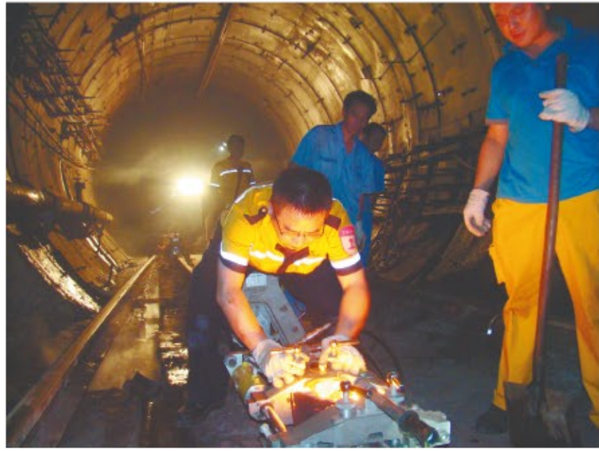
夜间,杨海滨还要走进隧道检修轨道。
