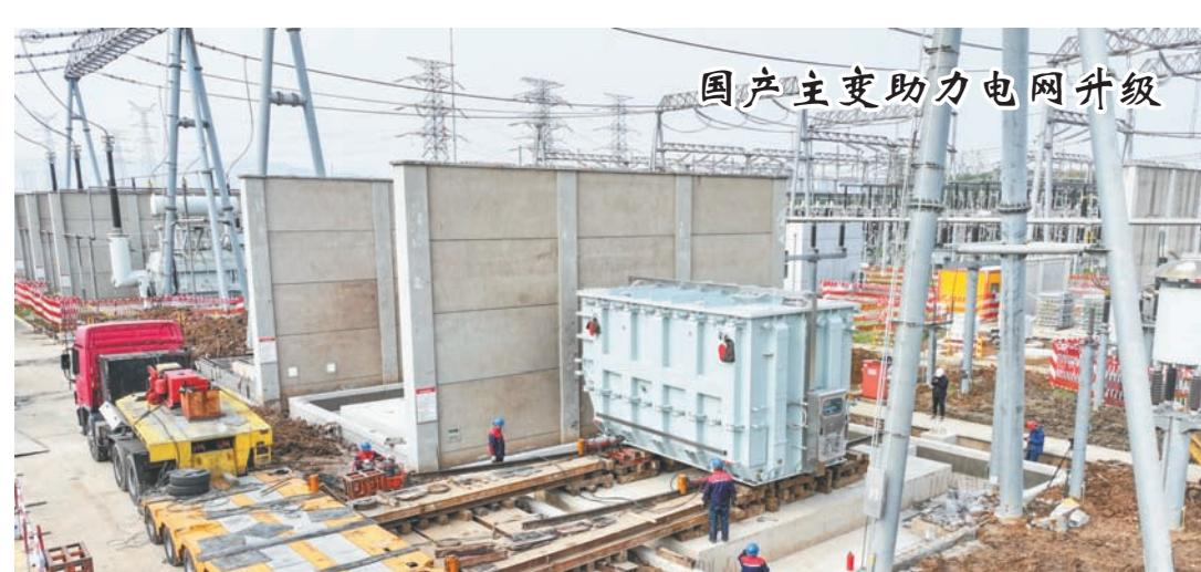
10月28日，江苏镇江上党500千伏变电站主变增容工程现场，一台长5.7米、宽3.2米、高10.2米、重228吨的主要变压器由巨型拖板车运达。此次工程是将750兆伏安进线主变更换为1000兆伏安国产主变，投运后可满足当地用电增长需求，为镇江发展提供电力保障。史俊 摄
