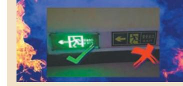
疏散指示标志应保持通电、常亮且具备蓄电功能，并应设在醒目位置，固定牢靠、无遮挡，方向指示标志图形应指向最近的疏散出口或安全出口。
