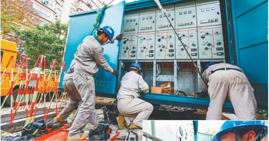
连日来,金湖县供电公司加大配网智能化项目改造,通过对老旧环网柜和柱上开关更新改造,实现配电系统的远程监控与控制,极大提高了配电系统的安全性和可靠性,保障了居民冬季高峰时段用电更可靠。图为11月19日,该公司组织电力工人在10千伏金华线名人家环网柜实施智能化改造。 梁德斌 摄
