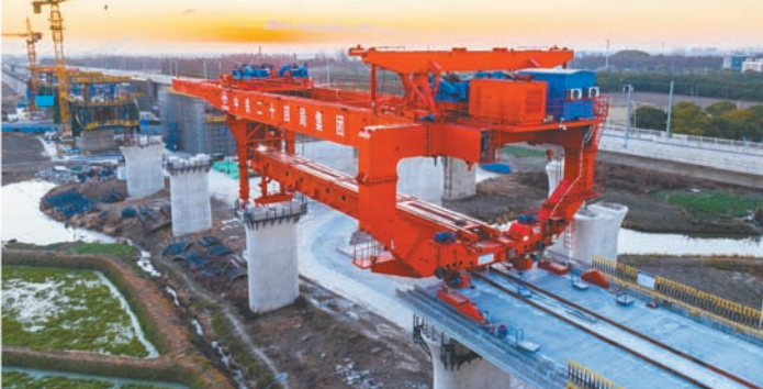
1月10日,北沿江高铁沪宁段站前Ⅲ标江苏省太仓市项目现场,铁路建设者正在进行连续梁施工、箱梁架设作业。北沿江高铁是国家“八纵八横”高速铁路网的重要组成部分,正线长度553.762公里,设计速度350公里/小时,全线设16座车站。目前工程各施工节点按施工进度稳步推进。 计海新 摄
