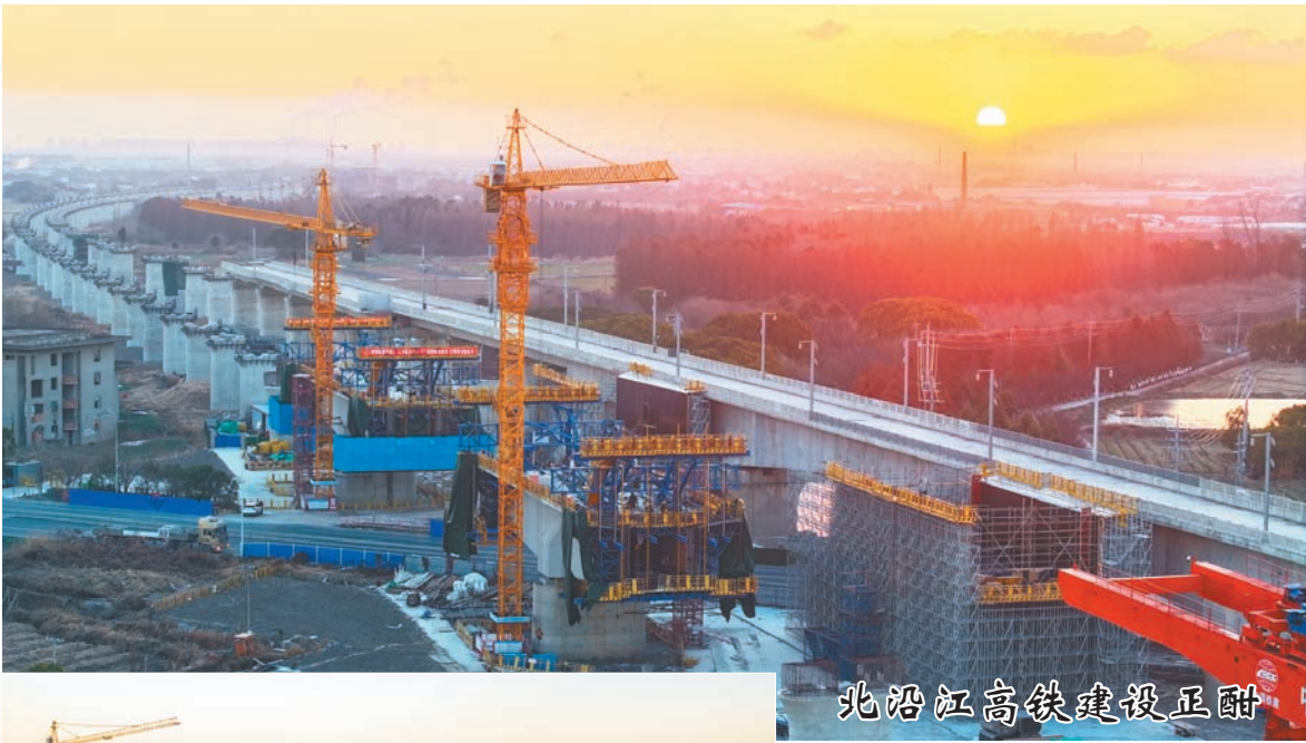
1月10日,北沿江高铁沪宁段站前Ⅲ标江苏省太仓市项目现场,铁路建设者正在进行连续梁施工、箱梁架设作业。北沿江高铁是国家“八纵八横”高速铁路网的重要组成部分,正线长度553.762公里,设计速度350公里/小时,全线设16座车站。目前工程各施工节点按施工进度稳步推进。 计海新 摄
