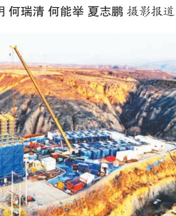
2月25日,夕阳下,延川南煤层气田14台全电动泵助力煤层气井高效储层改造(山西)
