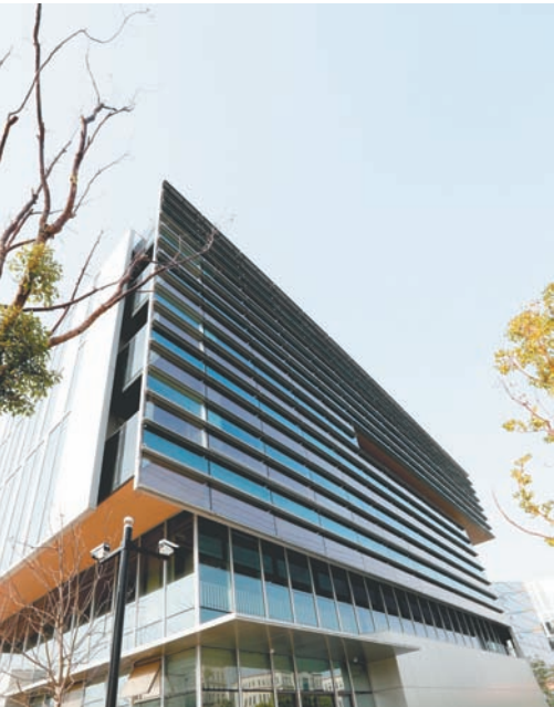
B1 号楼集展示和科研为一体,其光伏玻璃幕墙每小时能发电 11.5 度。 万森 摄
