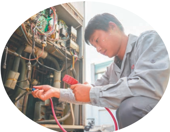
6月24日，许俊杰在江苏大学一处教学楼楼顶对中央空调外机进行维护。
