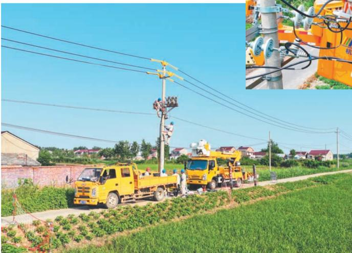
▲7月15日,金湖县供电公司带电作业班技术人员,冒着高温,为10千伏横桥线高压排支线路9号杆塔接线路,更换高压排旁站智能柱上设备,保障汛期用电安全可靠。 梁德斌 摄
