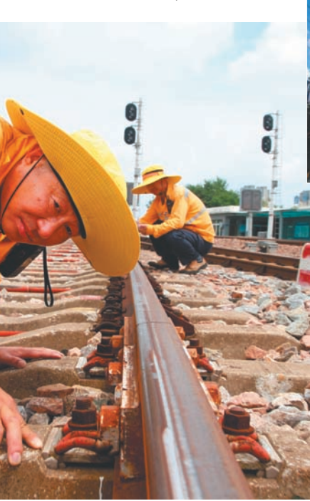
7月29日,铁轨被烈日晒得滚烫,轨温超过50℃,上海铁路局集团徐州北站的“轨道医生”们,来回穿梭在股道和道岔间,面朝石渣和轨枕,一丝不苟仔细排查,及时掌握钢轨状态,确保暑期铁路运输安全畅通。
