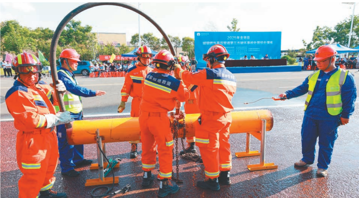
7月29日，淮安市金湖县住房和城乡建设局联合应急管理、发改、公安、消防、燃气公司、中国石油管道局工程有限公司维修分公司等单位开展“城镇燃气高压管道第三方破坏事故处置综合演练”。演练模拟城镇燃气高压管线遭施工破坏造成泄漏后，第一时间启动《金湖县城镇燃气事故应急预案》，成立多支抢险抢险小组制定修复方案、更换受损管道、抢修漏气点，全流程检验了各参演单位应对燃气突发事件的应急处置能力。图为参演人员正在进行抢修漏气点。陈剑 王洋 报道
